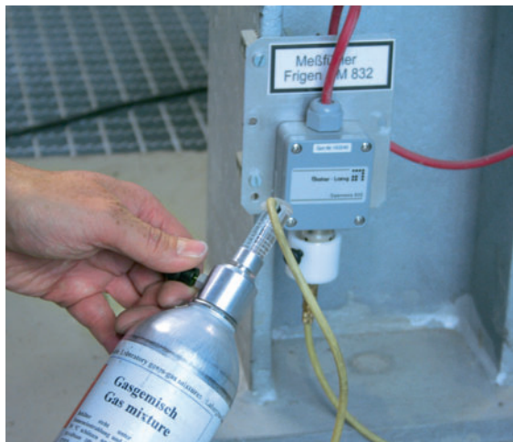
Abbildung 5: Ein Gassensor in Bodennähe wird mittels eines Testgases auf seine Funktion geprüft.
