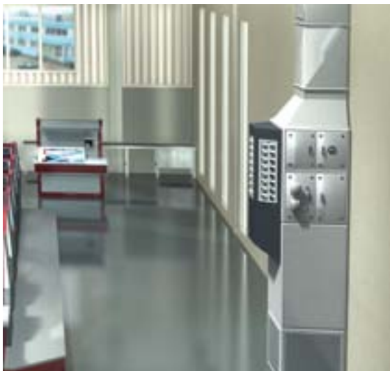
Luft zur Eliminierung der Maschinenabwärme. Umluft zur Reduzierung der Staubbelastung und zur Wärmerückgewinnung.
